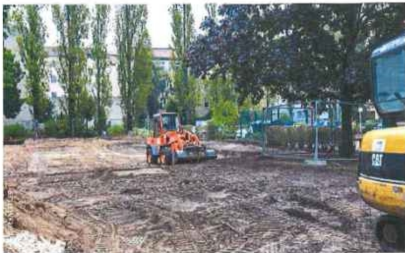
Bauarbeiten für den neuen Spielplatz Adam-/Jägerstraße.
